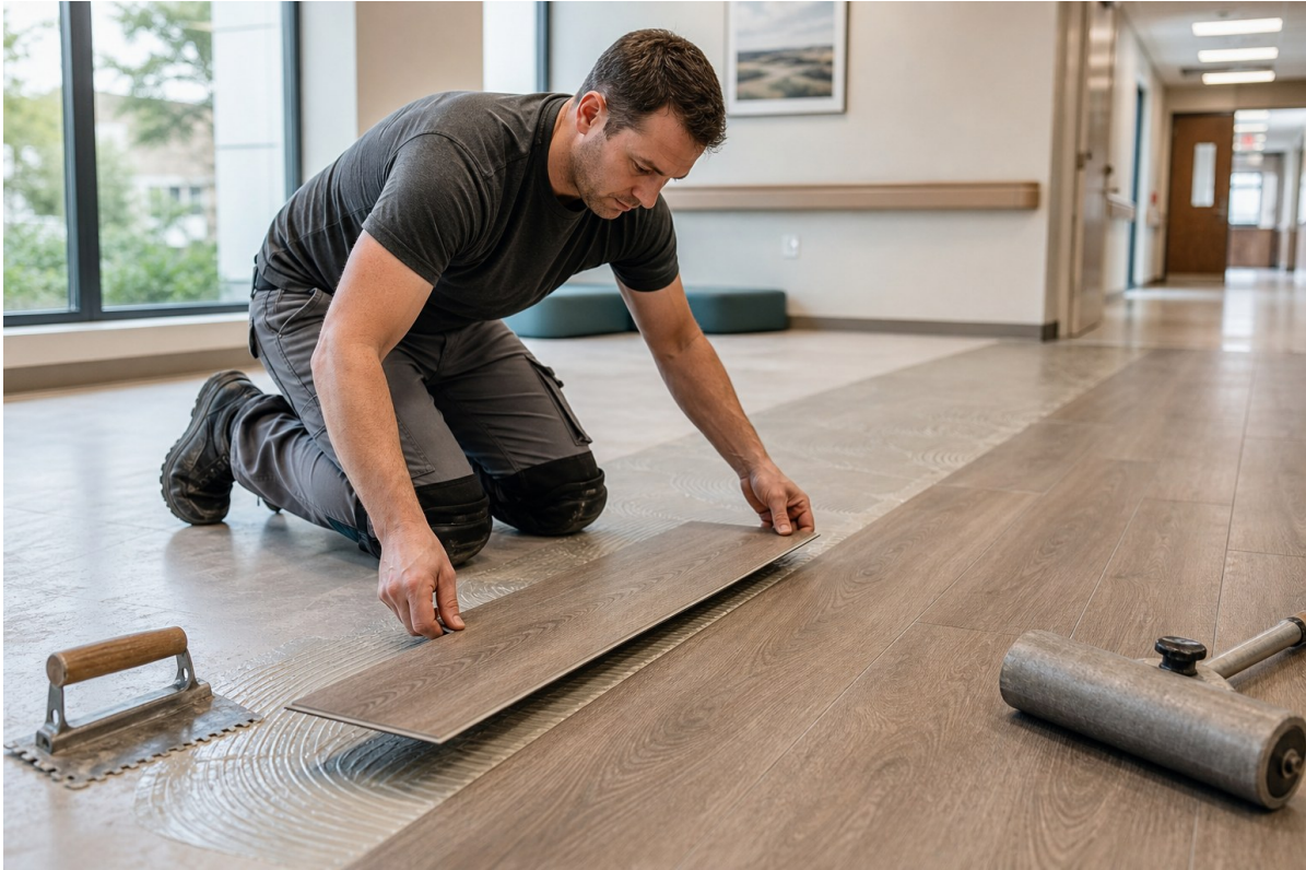
Ilustración 4. Instalación profesional de tablón LVT adherido sobre una base preparada.
