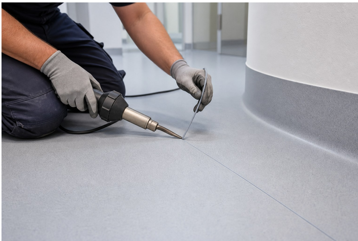
Ilustración 3. Soldadura en caliente de una junta de vinilo homogéneo con zócalo sanitario.
