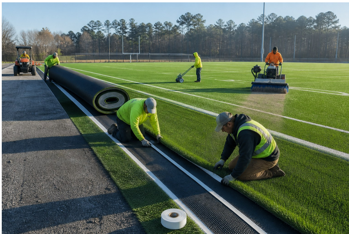
Ilustración 8. Alineación, unión y cepillado durante la instalación de una cancha sintética.
